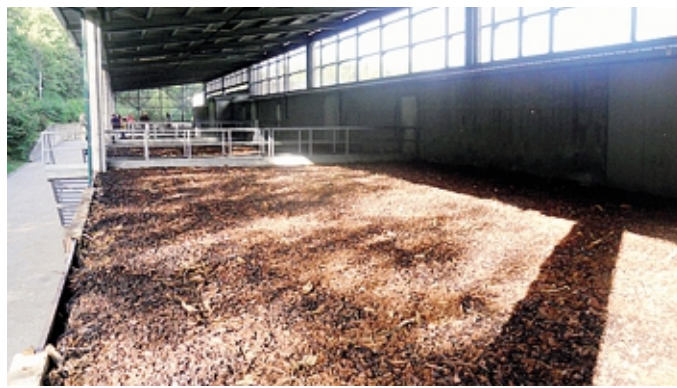
Il biofiltro dell'impianto di compostaggio
