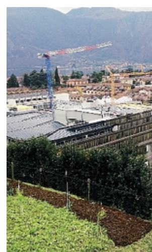
I lavori al nuovo stabilimento
